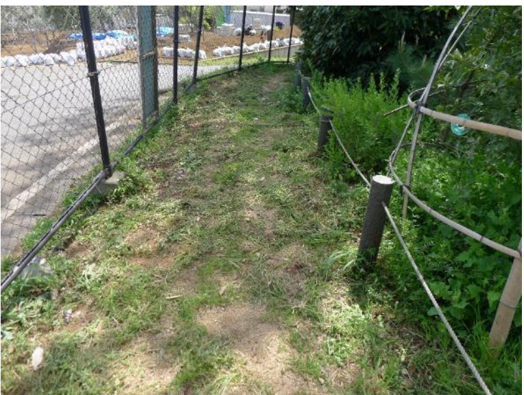
かまくら道草刈り作業終了状況 8
