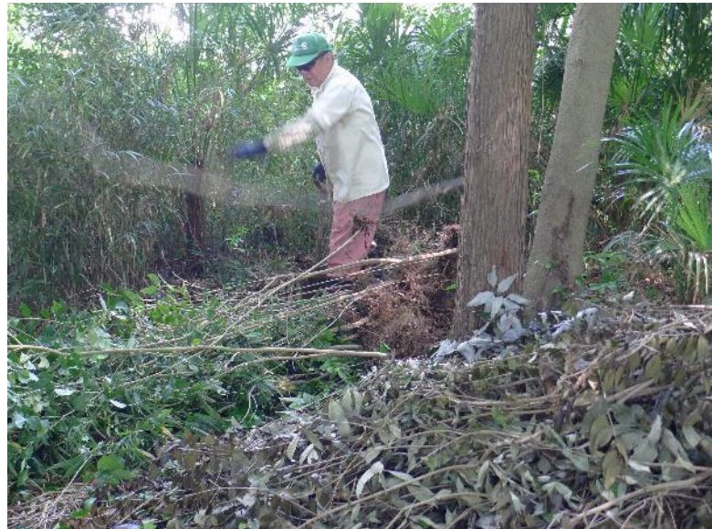
奥の細道散策路脇の雑木除去作業状況 1
