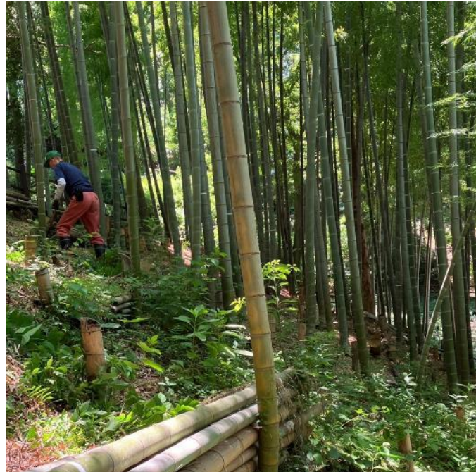
県道側部の折れた竹の片づけ作業状況 4
