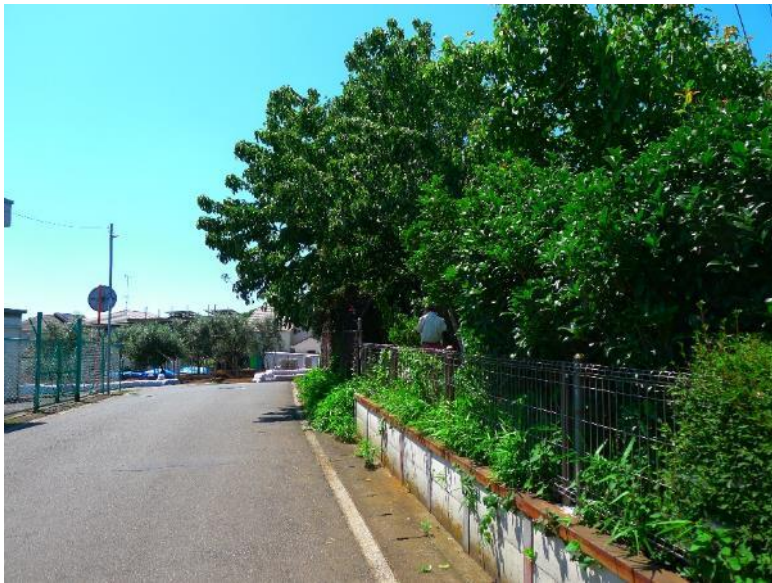
市道へのはみ出し枝の除去作業前状況 1
