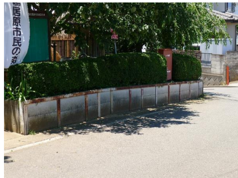
市道側頂上部生垣刈込作業終了状況 9
