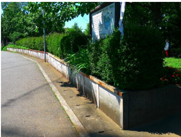
ハンカチノキ広場の市道側生垣刈込作業前状況 2
