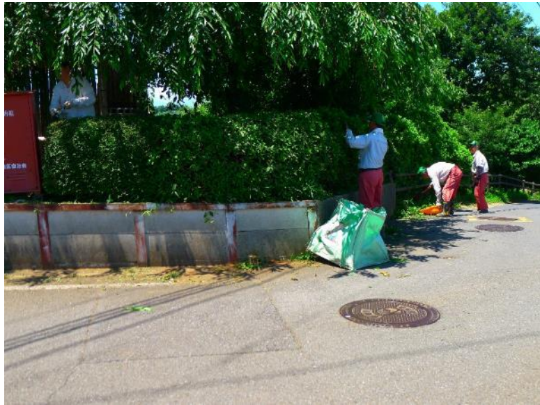
市道側頂上部三差路生垣刈込・収集・清掃作業状況 6
