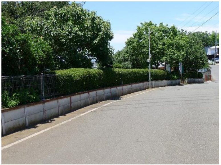
市道側生垣刈込作業終了状況 10
