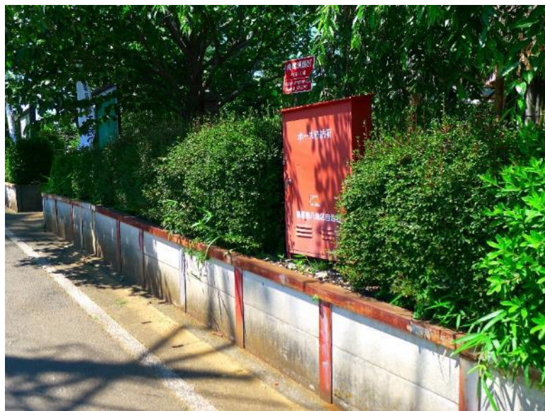
ハンカチノキ広場の市道側生垣刈込作業前状況 1
