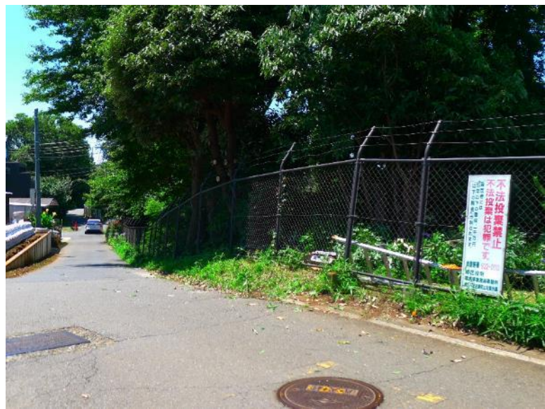
市道へのはみ出し枝の除去作業前状況 2
