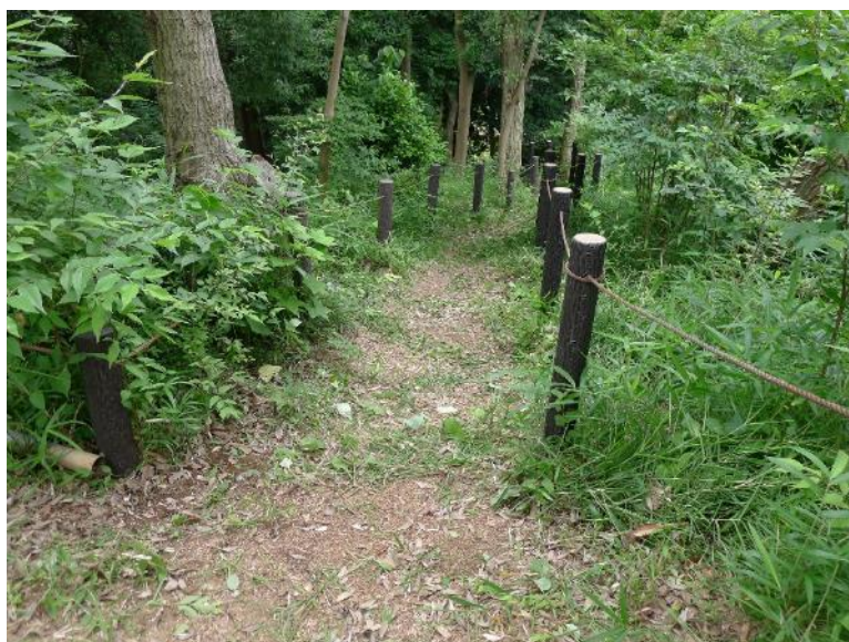
タイヤ道～奥の細道分岐部草刈り作業終了状況 1
