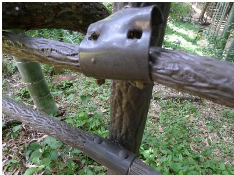
擬木柵木に倒木がダイレクトに衝突し金具破損状況 3
