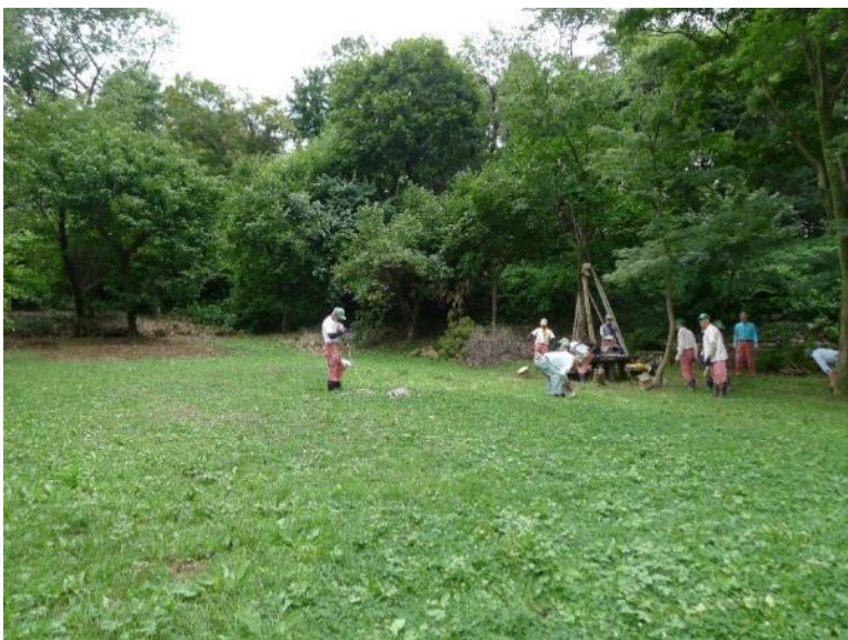
ふれあい広場モミジ伐採作業終了状況 4
