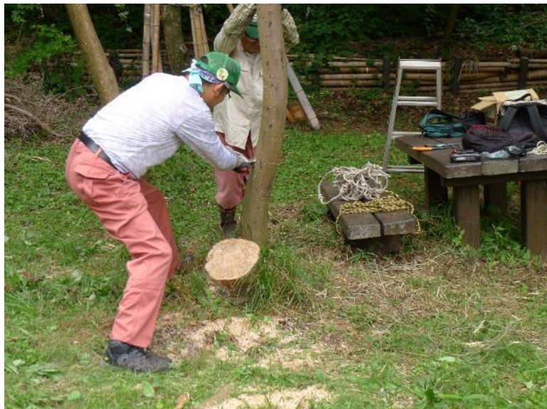
モミジ伐採手引き切断作業状況 3
