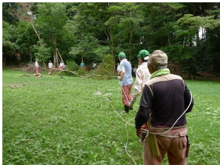
モミジ先端ロープ掛け伐採作業終了 4
