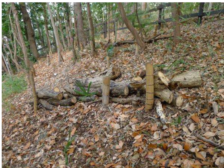
玉切り材を粗朶柵として利用作業終了状況 4
