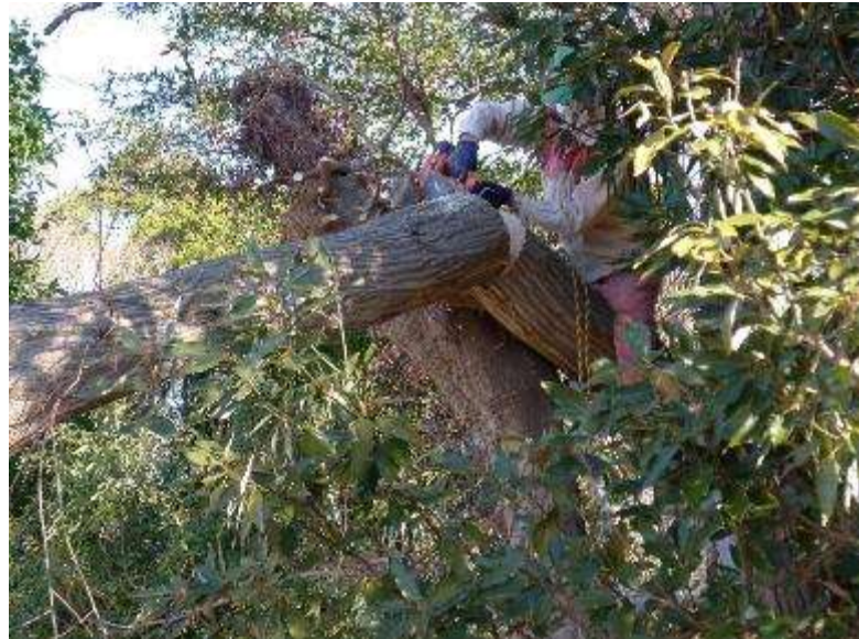
ナラノキ伐採作業状況 5-6
