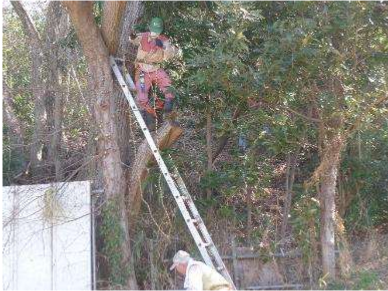
ナラノキ高木伐採作業準備状況 1
