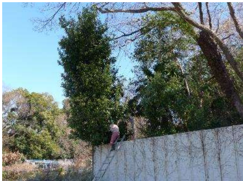
檜の木の伐採作業開始前状況 1
