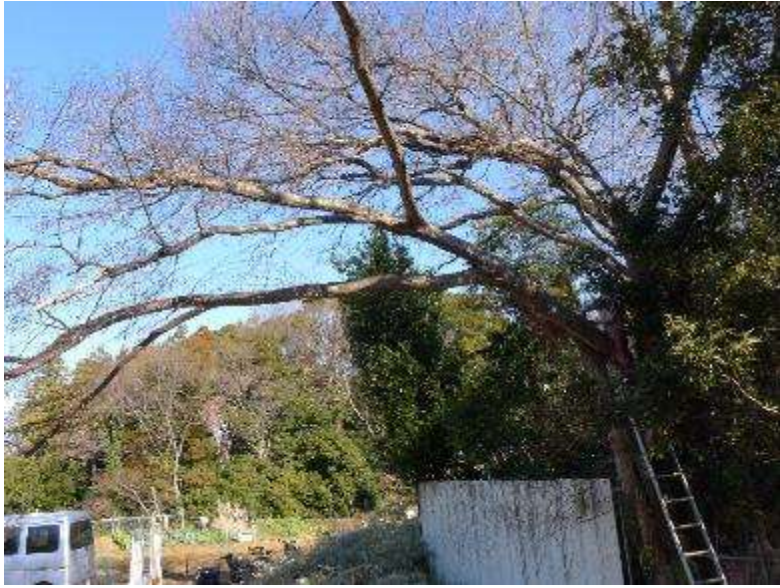
ナラノキ伐採作業状況 5-2
