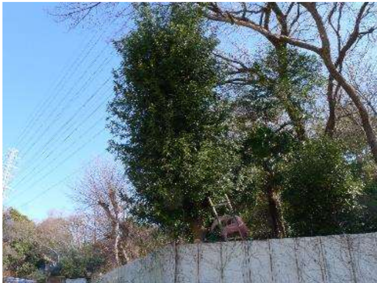
榿の木の伐採作業状況 5
