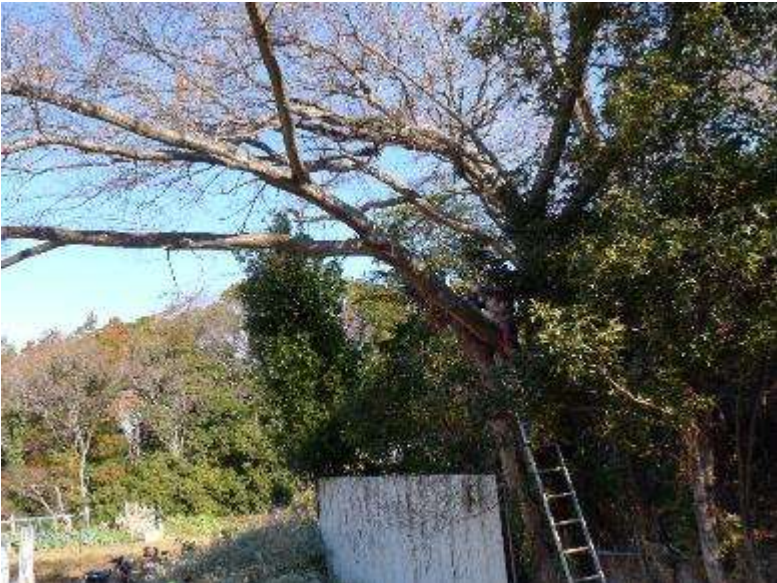
ナラノキ伐採作業状況 5-2
