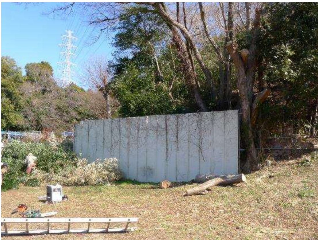
ナラノキ・榎の木伐採作業終了状況
