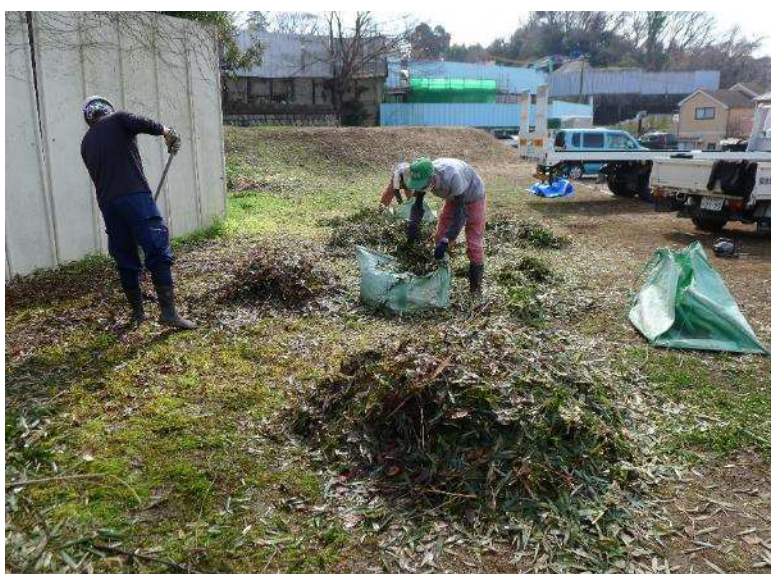
竹・樹木チップ化作業進捗での片付け作業状況 8
